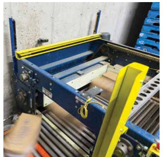
Des barrières immatérielles de sécurité Omron F3SG ont été installées sur la station de palettisation.
