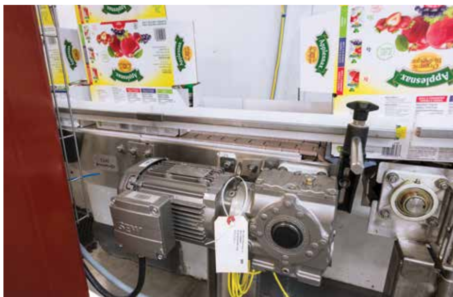
Une unité SEW-Eurodrive installée sur une bande transporteuse.
